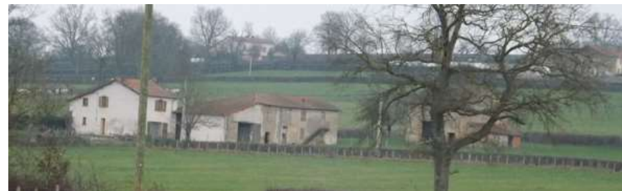
Exemples d’habitations anciennement agricoles, avec la présence d’anciennes granges ou anciens bâtiments agricoles.
